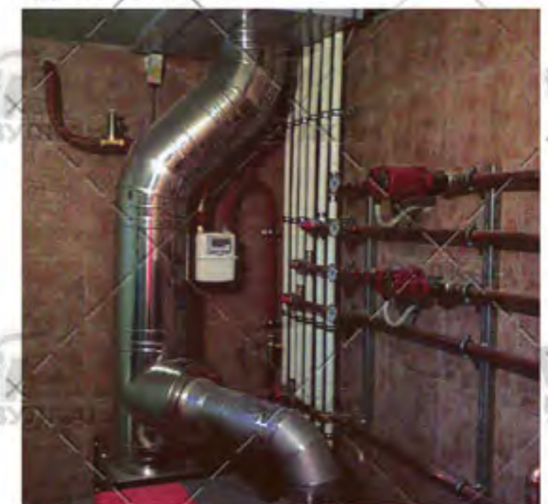
Котельная. Парголово трубы \varnothing 160/260
